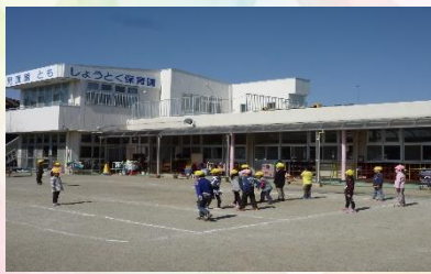
園舎は2階建てで、 広い園庭もあります！
